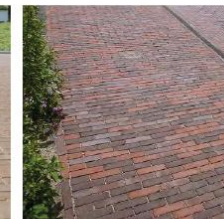
bestrating mix van nieuw en bestaande klinkers
