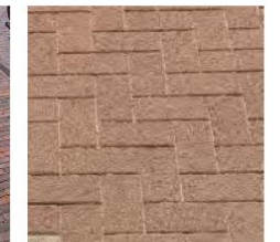
rijbaan geluidsreducerende verharding
